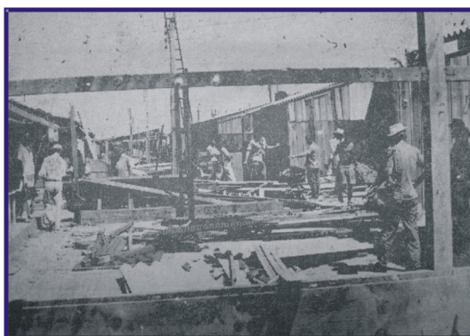
Fig. 2 - Demolição das barracas do mercado do Cais de Santa Rita.
